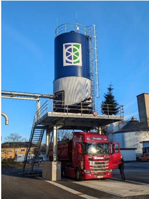
Verladung von Klärschlamm aus dem Hochsil
